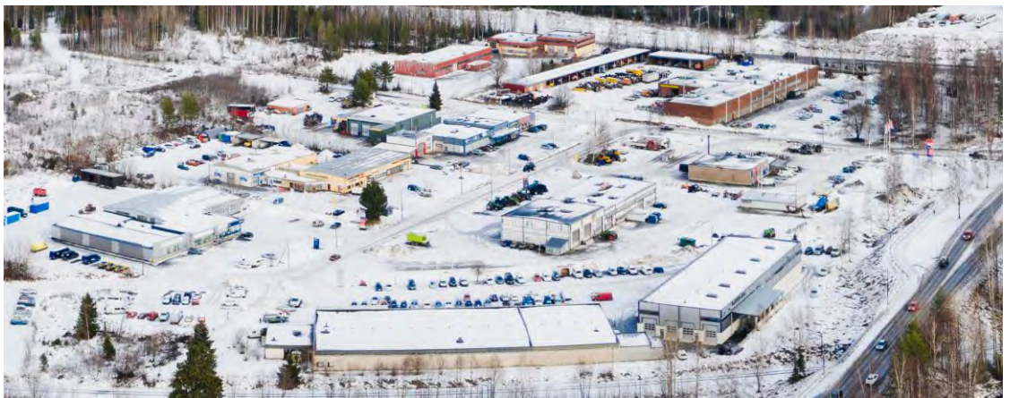
Kaapelikadun yritysalue lounaasta. Oikealla Otavankatu ja takana valtatie 13.
